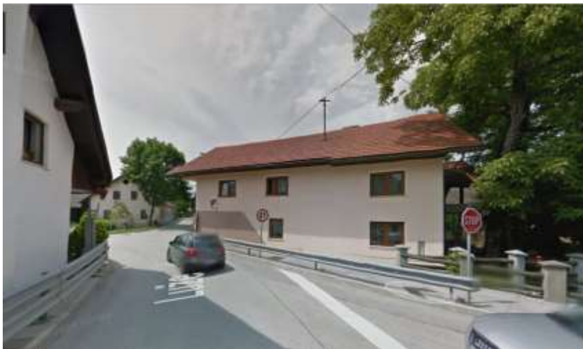
Slika 5: Odsek na cesti Luže – Visoko - Srednja vas je zelo nevaren zaradi nepreglednosti.
