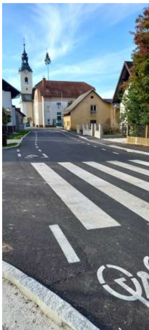
Slika 2: Pogled na prehod za pešce na cesti Šenčur – Voklo – na začetku vasi Voklo. Prehod je dobro pregleden, na obeh straneh ceste pa je pločnik.
