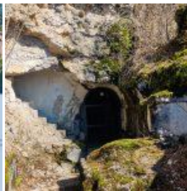
Obrambni bloki pred vhomom v bunkeru.
