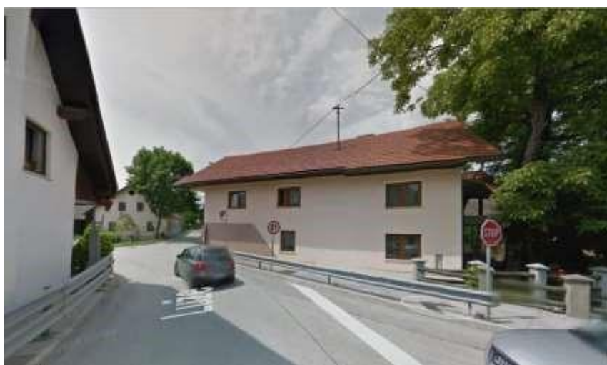
Slika 8: Odsek na cesti Luže – Visoko - Srednja vas je zelo nevaren zaradi nepreglednosti.
