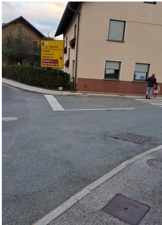
Slika 4: Prehod za pešce v križišču, kjer cesta iz smeri Milj zavije proti Lužam / Cerkljam (nasproti gostišča Kovač), je preslabo označen ter nepregleden v desnem ovinku, pri čemer vozniki spregledajo znak za prehod in v križišče zapeljejo z neprilagojeno hitrostjo. Premajhna oddaljenost prehoda od križišča ne omogoča pravočasnega zaviranja ob neprilagojeni hitrosti in s tem resno ogroža varen prehod.
